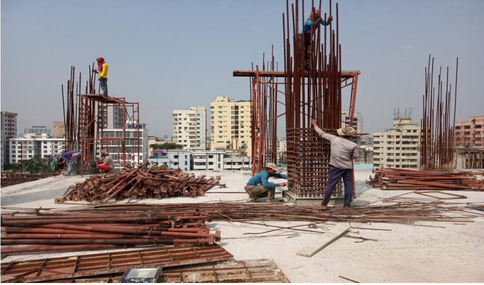
ওয়াক্ফ ভবনের ৭ম তলা ছাদের নির্মাণ কার্যক্রম
